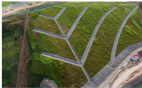
Рис. 8. Осушение оползневого склона
